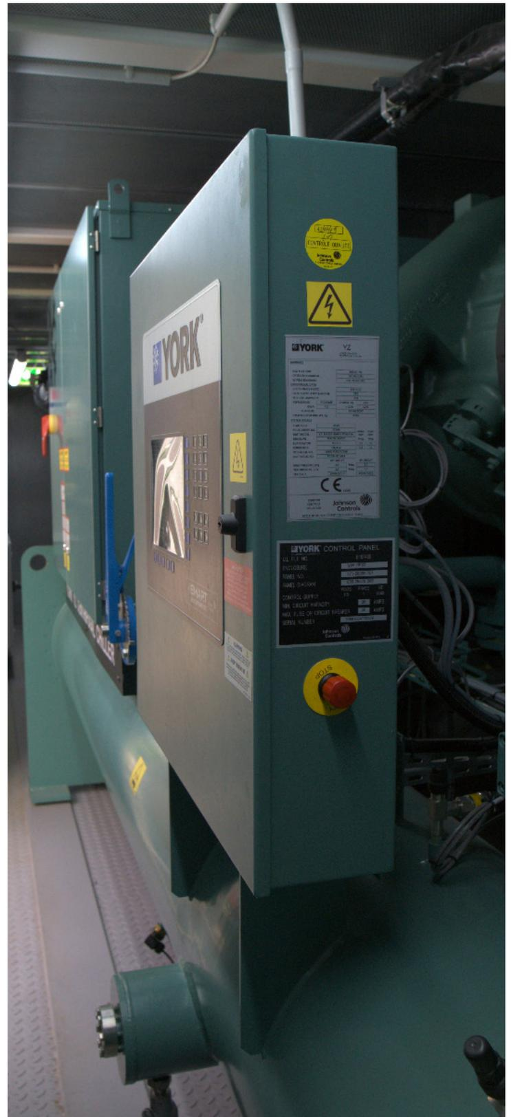
Die wassergekühlte YORK YZ Kältemaschine von Johnson Controls wird bei Katjes mit mechanischer Freikühlung betrieben und ermöglicht auf diese Weise große Energieeinsparungen. Ihr Wirkungsgrad liegt bei 9. (Bild: Johnson Controls)
