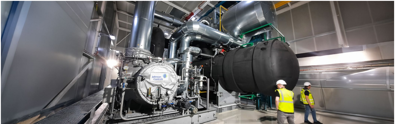
Die rund 255 Tonnen schwere Großwärmepumpe von Johnson Controls wurde in die bestehende Maschinenhalle des EnBW-Heizkraftwerks in Stuttgart-Münster integriert – bei laufendem Betrieb. (Bild: Johnson Controls)
