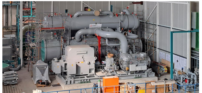
Ein Leuchtturmprojekt: Die neue Großwärmepumpe am EnBW-Standort Stuttgart Münster (hier während der Montage) dient als Vorbild für ähnliche Anwendungen bundesweit. (Bild: EnBW Stuttgart)
